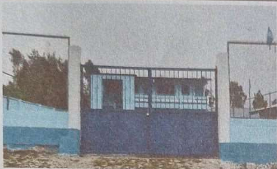
Foto 1: Sustrucción de portón de metal, entrada principal a módulos I y II
