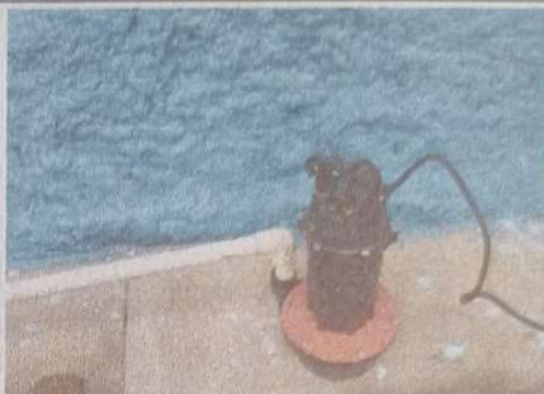
Foto 8: Sustitución de bomba de agua
