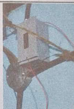
Foto 4: Sustrucción de flipones, en el módulo I
