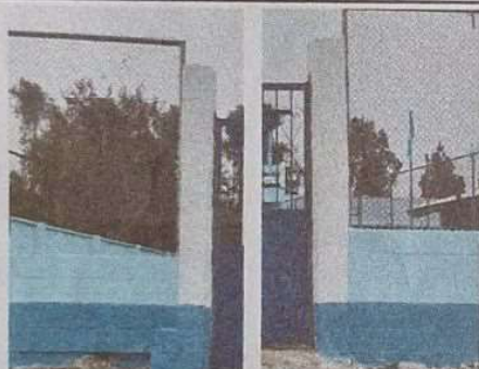
Foto 3: Reparación en muro perimetral de blok
