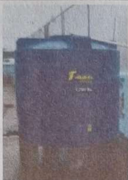
Foto 7: Sustitución de depósito de agua 1700 litros.
