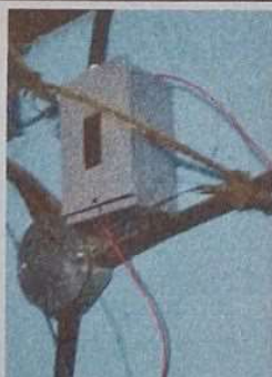
Foto 5: Sustrucción de tablero de flipon, modulo I
