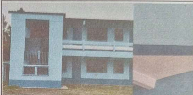
Foto 2: Pintura en muros exteriores del establecimiento.
